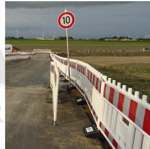
Bauzaun im Baufeld
